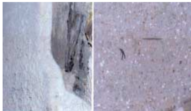
2 Tunnelelement mit 5 cm Perlit-Brandschutzschicht nach Brandlast 180 min RWS-Tunnelkurve (l.) und nach Brandlast 120 min bei 1200 °C ohne Schutzschicht (r.)
